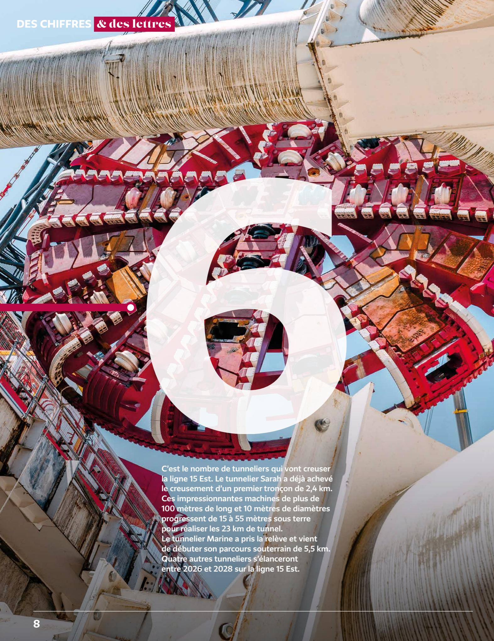
C'est le nombre de tunneliers qui vont creuser la ligne 15 Est. Le tunnelier Sarah a déjà achevé le creusement d'un premier tronçon de 2,4 km. Ces impressionnantes machines de plus de 100 mètres de long et 10 mètres de diamètres progressent de 15 à 55 mètres sous terre pour réaliser les 23 km de tunnel. Le tunnelier Marine a pris la relève et vient de débuter son parcours souterrain de 5,5 km. Quatre autres tunneliers s'élanceront entre 2026 et 2028 sur la ligne 15 Est.
