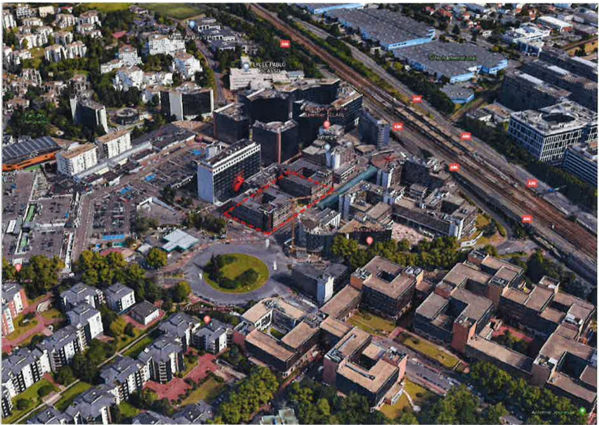
Localisation du bâtiment existant sur l'avenue du Val-de-Fontenay
