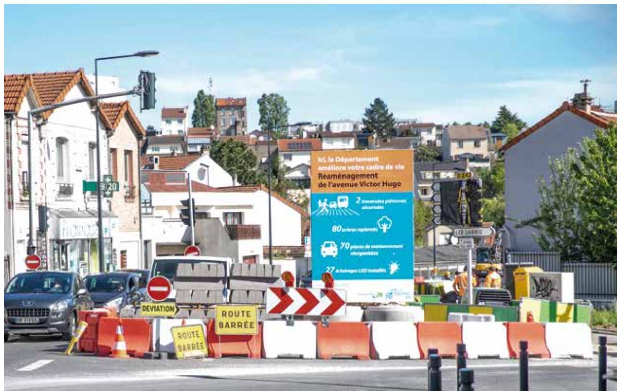
Pendant les travaux av. Victor-Hugo, la circulation est neutralisée dans le sens descendant.
