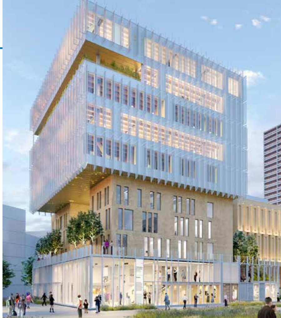
Le nouvel équipement de 4300 m 2 devrait voir le jour d'ici la fin 2022.
