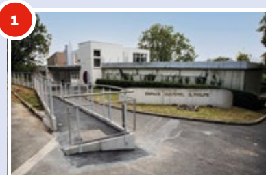
TRAVAUX AD'AP À L'ESPACE GÉRARD-PHILIPPE ET AUX STUDIOS JOE-TURNER
