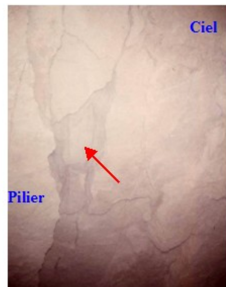
Figure 28. De gauche à droite : pilier, zone de broyage et ciel fissuré [Source : LREP, 1987]
