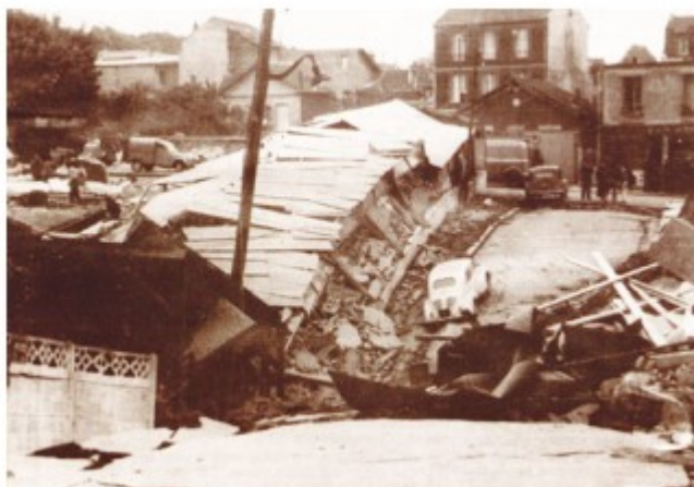
Figure 13. Effondrement généralisé à l'aplomb d'une carrière de craie de Clamart (92)
