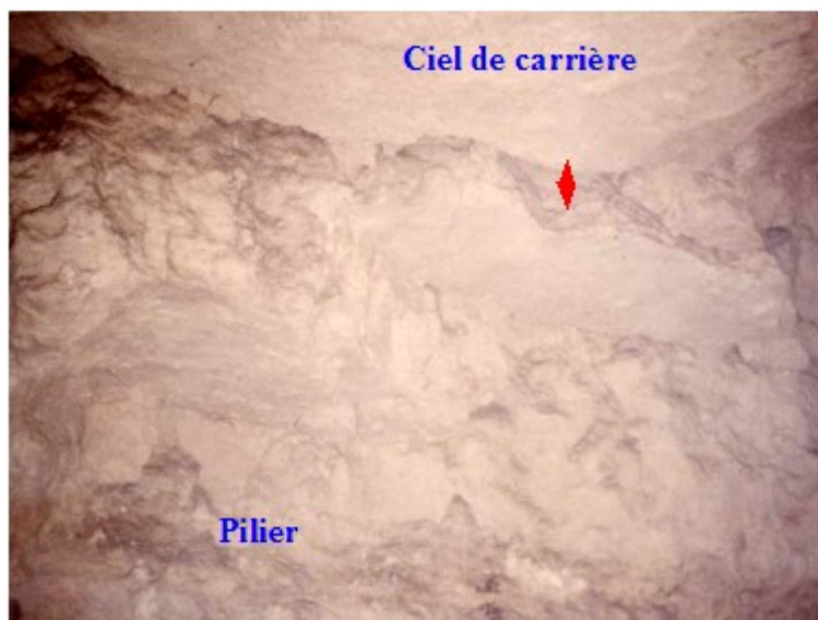
Figure 27. Ciel de carrière (en haut) et pilier très affecté : décrochement supérieur à 40cm [Source : LREP, 1987]
