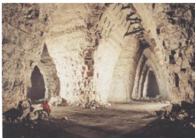
Figure 8. Piliers tournés (Carrière de Gypse 1ère masse) [Source : Atlas du Paris souterrain]
