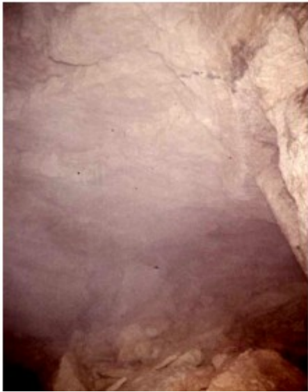
Figure 25. Pilier (à droite) et ciel très fissuré [Source : LREP, 1987]
