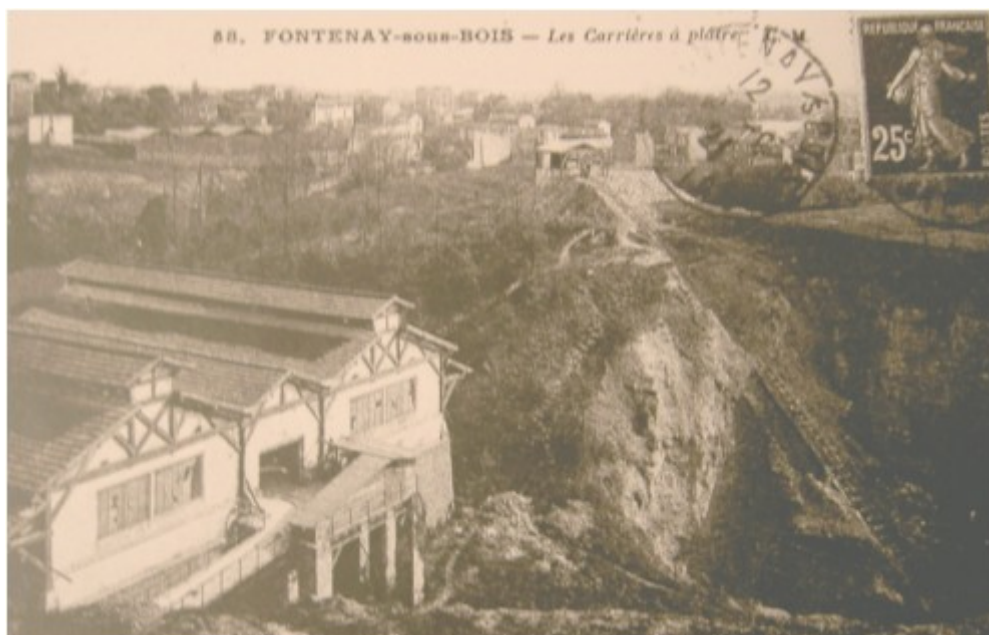
Figure 21. Carte postale de Fontenay-sous-Bois. Présence d'un rail utilisé pour remonter les wagonnets remplis de Gypse [Source : Ballade au temps passé]
