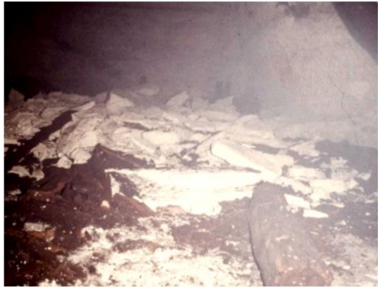
Figure 26. Débris de Gypse issu d'un ciel tombé et poutrage tombé [Source : LREP, 1987]
