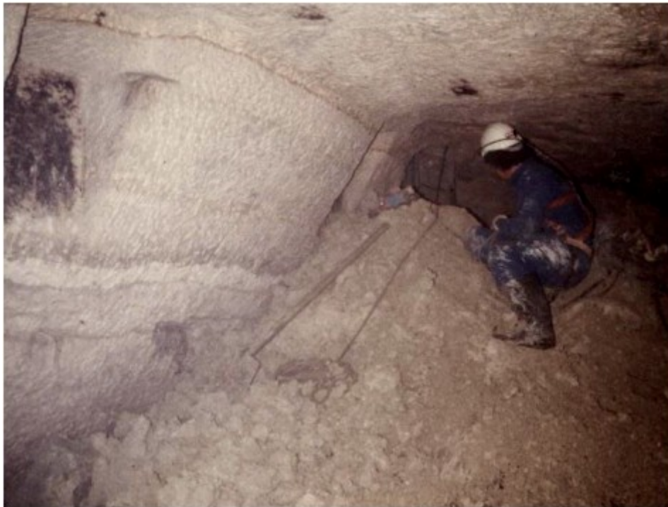
Figure 23. Sommet d'un pilier (à gauche) et éboulis issus du forage [Source : LREP, 1987]
